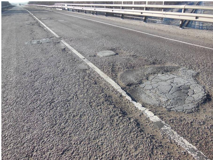
**Рис. 2.** Деформации и дефекты ездового полотна железобетонных мостов
