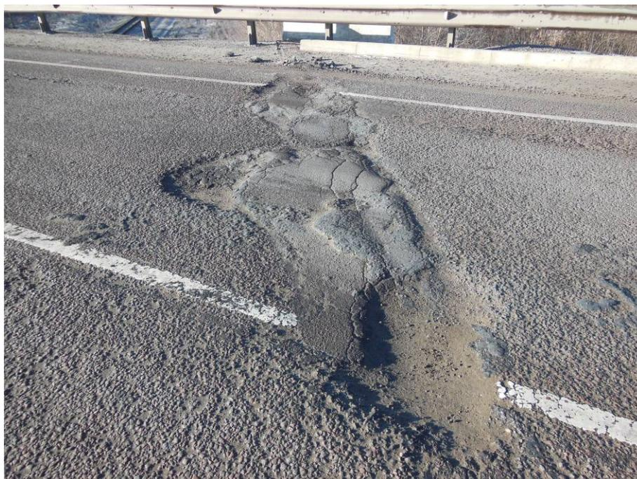
**Рис.4.** Разрушение асфальтобетонного покрытия в зоне деформационных швов
