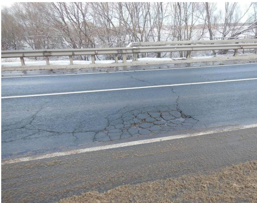
**Рис.3.** Разрушение асфальтобетонного покрытия под давлением воды:
